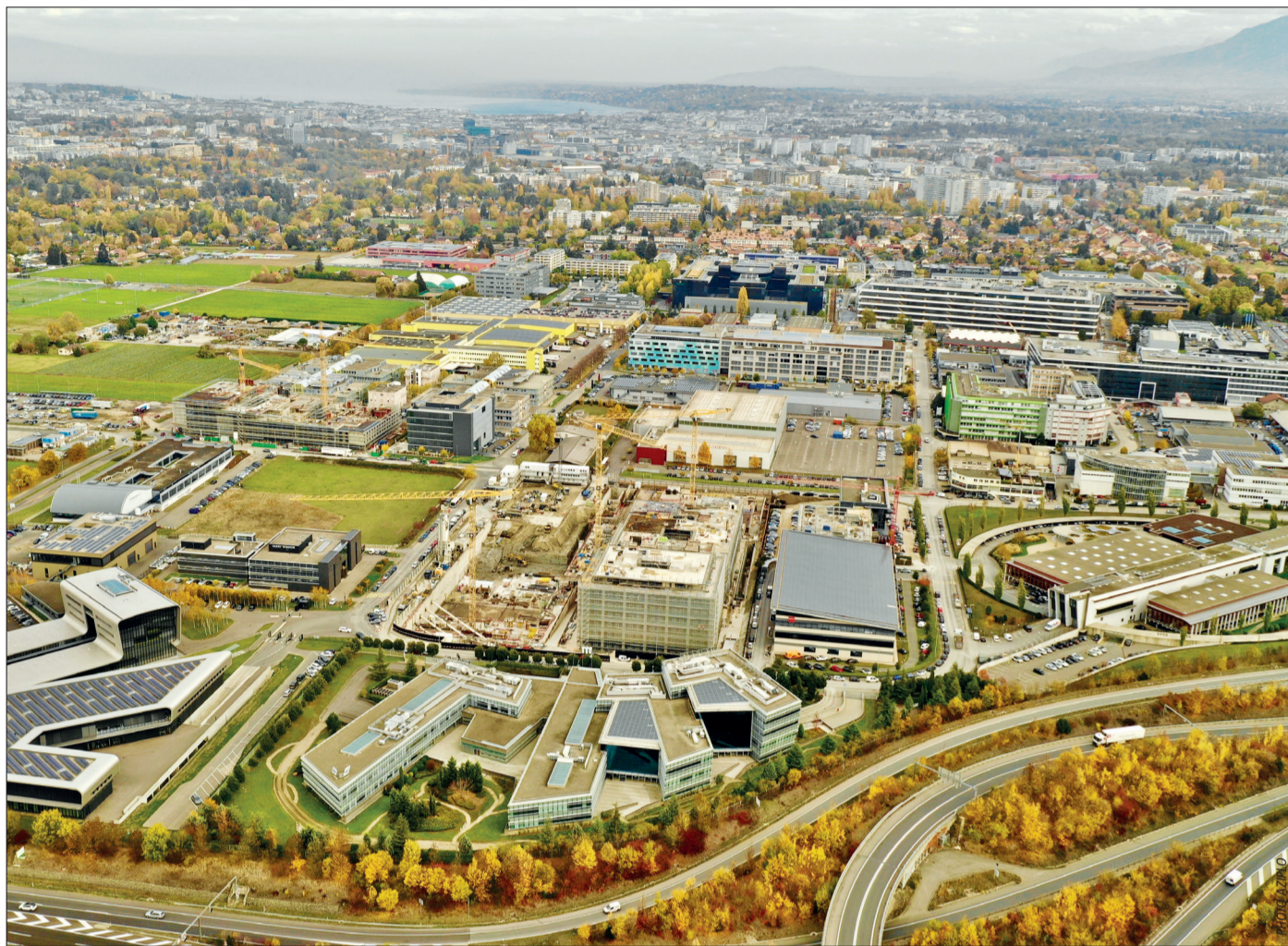
LA ZONE INDUSTRIELLE DE PLAN-LES-OUATES – ZIPLO – a entamé sa mue il y a plusieurs années (ici: en 2018). La construction de l'Espace Tourbillon, dès 2017 et achevé en 2022, est le dernier projet d'envergure en date.
